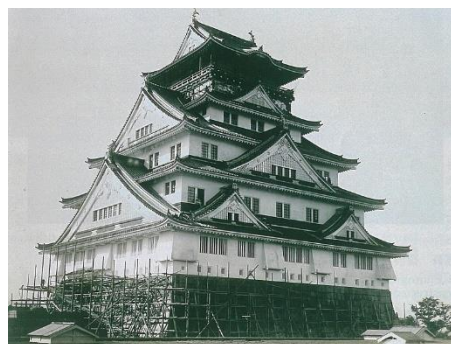
古写真 大阪城天守閣復興工事 完成間近
