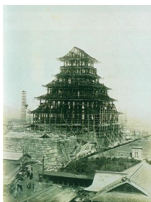
古写真 大阪城天守閣復興工事 鉄骨組み上げ完了（南東方向より）
